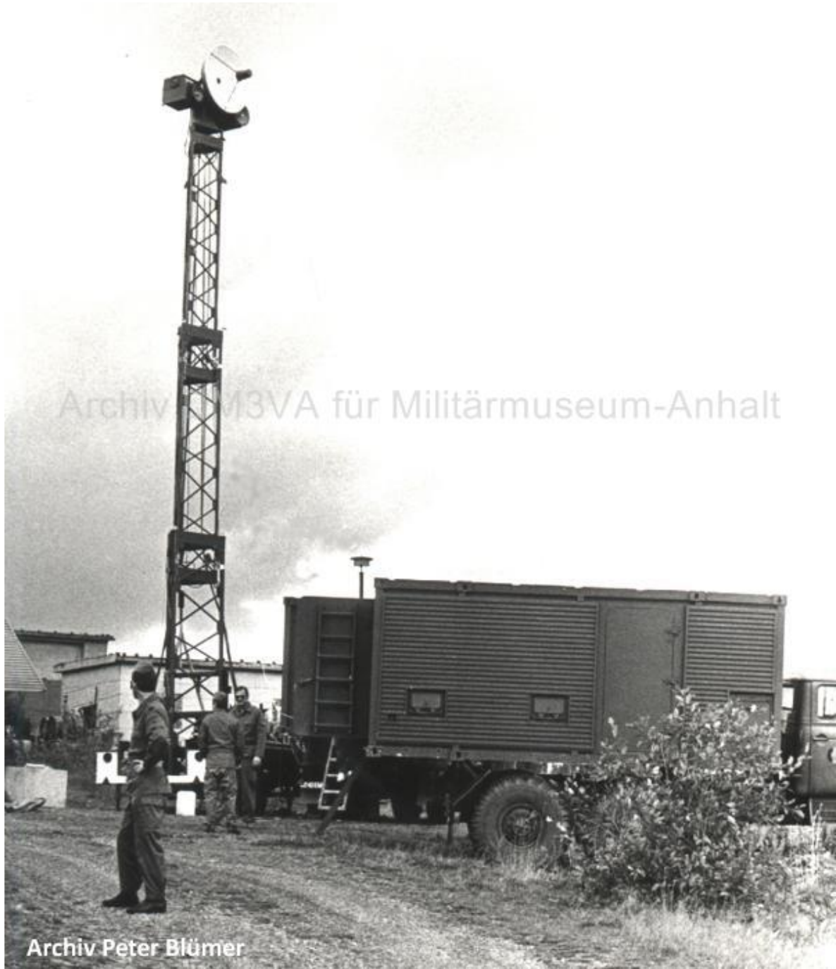
System BOLERO mit Antennenmast
