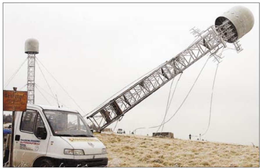
Eine schonende Methode, die wenig Verwundungen des Bodens garantierte, wählten die Mitarbeiter der Oberwiesenthaler Schlosserei König, als sie gestern die beiden „Stasi-Türme“ abbauten. — FOTO: BRIGITTE STREEK
