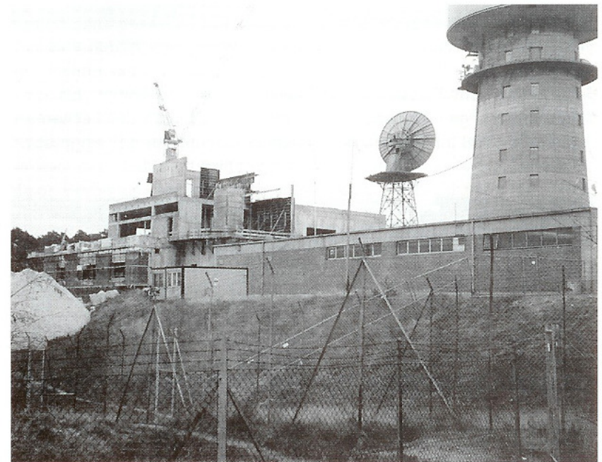
Die horizontale Erweiterung wird gebaut
